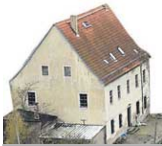
Ringelplatz-Geburtshaus Sanierungsbeginn im zweiten Halbjahr Seite 30
